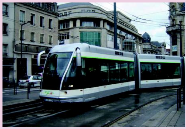
Vandoeuvre Les Nancy Aménagement de la ligne N°1 du Tramway sur pneus
