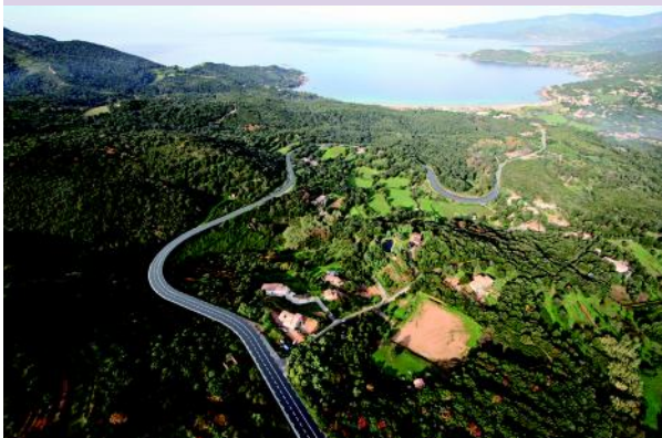
RD81 - CD 2A - Aménagements entre la Liscia et le Listinconu
