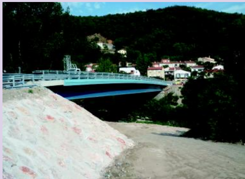
Pont de CAN BIA - ARLES SUR TECH Ouvrage mixte isostatique de 62 m de portée
