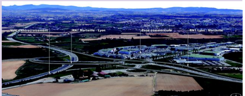
RN7 - DREAL Centre Est - Carrefour des Couleures à VALENCE
