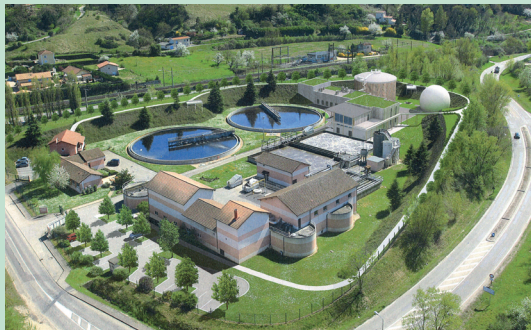
STEP Vienne SYSTEPUR (cogénération)
