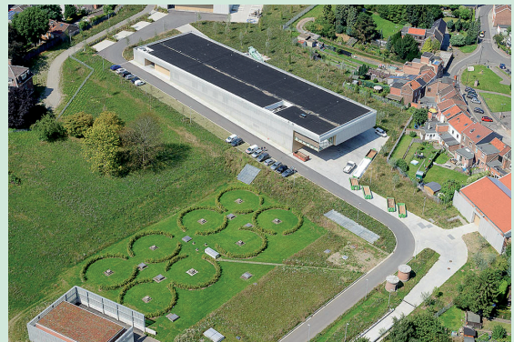
Usine d'eau potable de Liège
