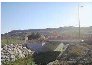
Ouvrage hydraulique de transparence
