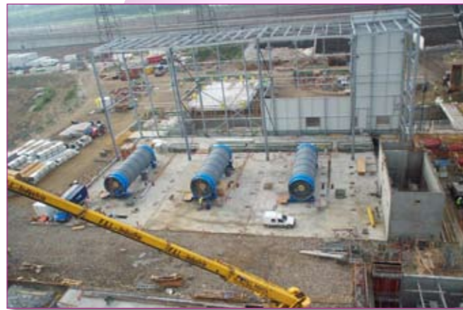
Construction de l'usine Seine Amont de Valenton juin 2004
