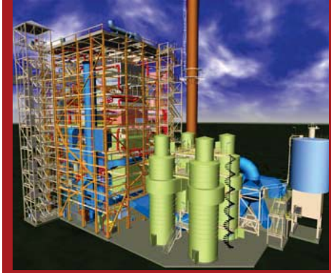
GRAND COURONNE - Raccordement SAIPOL (76) Centrale de cogénération à partir de biomasse (bois énergie) Spreader stocker 55 MWth - 9 MWé
