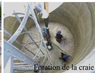
Construction du cuvelage par havage
