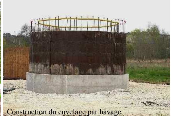
Construction du cuvelage par havage
