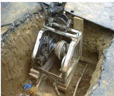
Extraction du plomb grâce à un treuil
