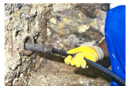
Le branchement en polyéthylène remplace en lieu et place le branchement en plomb lors de son extraction
