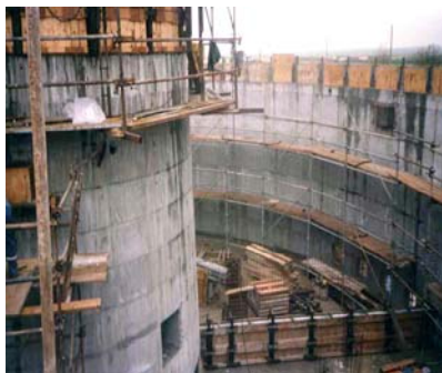
Parois de la bache et début d'élévation du fût
