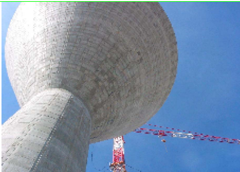
Vue de la coupole en fin de chantier
