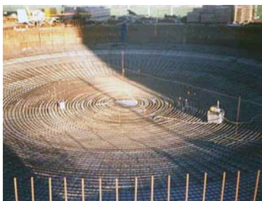
Ferrailage du radier de la bache
