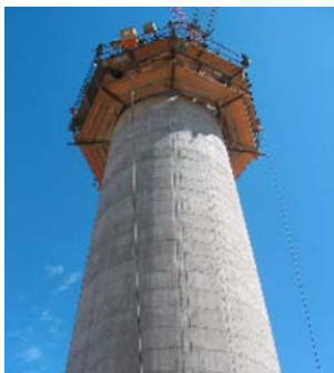
Début du coffrage de la coupole
