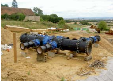
Assemblage des pièces de la chambre de raccordement sur les réservoirs de Boisement
