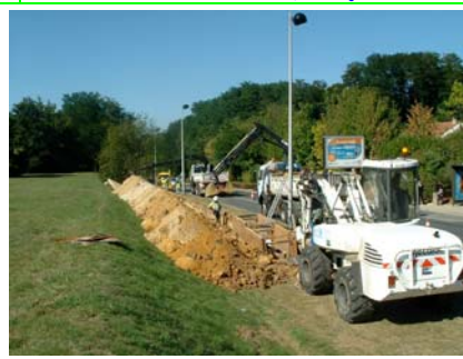
Pose le long du boulevard de l'Oise
