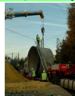
Opération de levage de la structure préfabriquée du puits de travail pour microtunnelier (grue de 100 tonnes)
