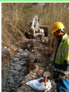
Passage sous chemin forestier avec terrains durs
